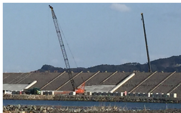
被災地の岩手県陸前高田市では、高さ12.5メートルの巨大な防潮堤の建設、かさ上げ工事の真っ最中。
