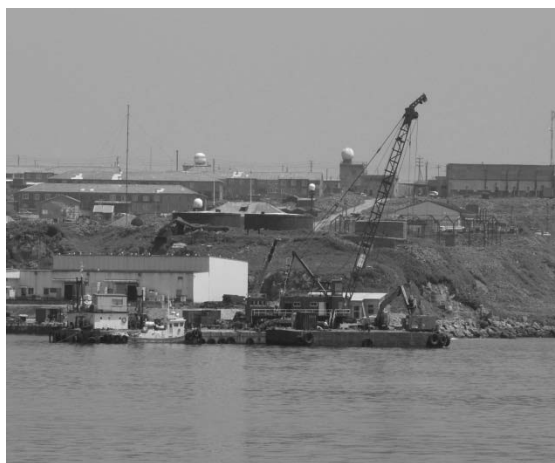
写真 1. 古釜布港の港湾整備（2011 年）
